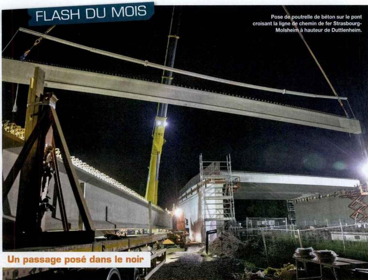
Pose de poutrelle de béton sur le pont croisant la ligne de chemin de fer Strasbourg-Molsheim à hauteur de Duttenheim.
