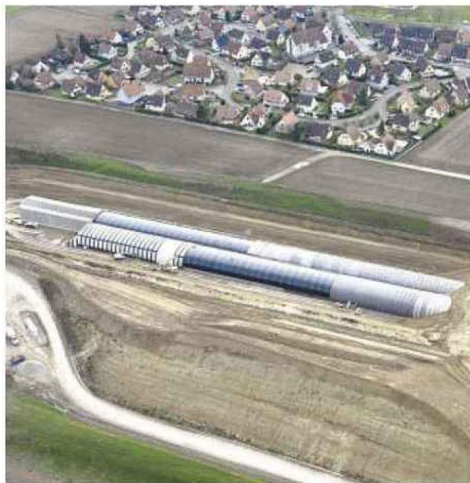
Environ un tiers des éléments en béton des ouvrages du COS, comme la tranchée couverte de Vendenheim, ont été préfabriqués.
