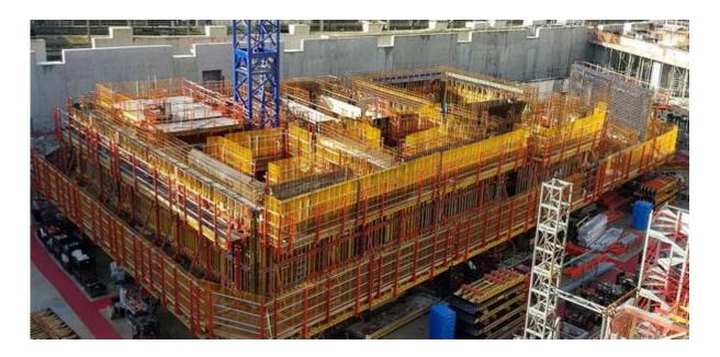
Dans le système auto-grimpants ACS de Systèmes Peri, les unités grimpantes comprennent le coffrage des murs et les passerelles. Elles se déplacent d'étage en étage grâce à leurs systèmes hydrauliques intégrés. La montée simultanée de plusieurs unités grimpantes renforce la sécurité du chantier en réduisant les bords à nu. Coffrage, décoffrage et montée hydraulique se succèdent très rapidement. Les passerelles abritent le personnel de chantier du vent et des intempéries. ©Peri France
