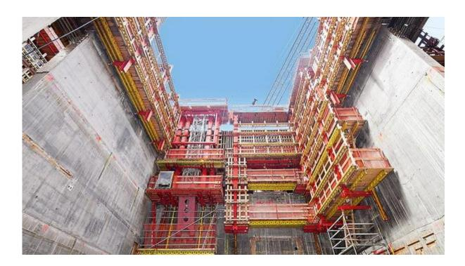
Grâce à la technique auto-grimpante ACS, les mâts de bétonnage et les tours d'accès suspendues sont hissées conjointement, toujours sans grue. Ce type d'outil a notamment été utilisé pour les piles du Viaduc de Millau. ©Peri France
