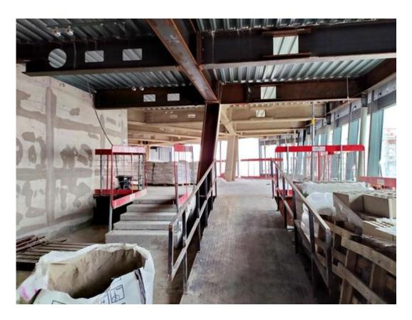
La batterie moyenne (seconde en partant du bas) de la tour Duo 1 possède une structure mixte béton et charpente acier. Tandis que la batterie 3 de la tour Duo 1 est en tout acier autour du noyau : poteaux, poutres et bacs acier collaborants pour les planchers. ©PP
