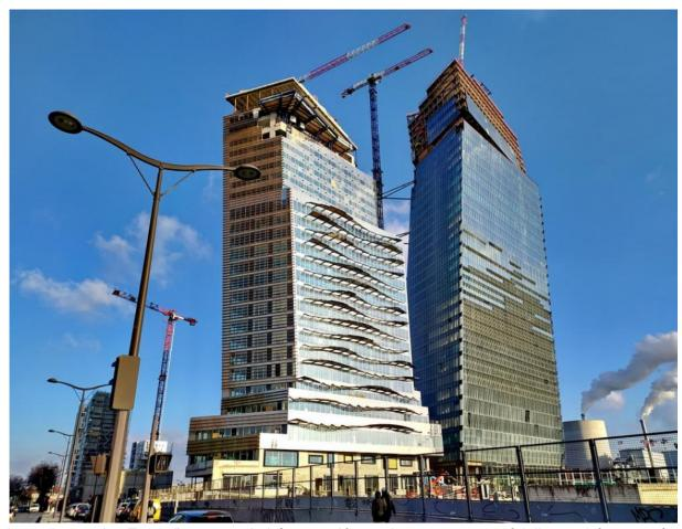
La structure des Tours Duo associe béton coulé sur site, poutres et prédalles en béton armé préfabriqués, poutres acier et plafonds acier collaborants.
