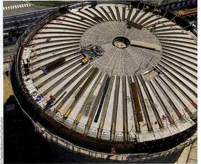
chantier le béton C40/50 XC4 – XS3 – XD3 – XF1 – XA3 Classes d'exposition, et le ciment Calcia CM3 52.5L PMES.
