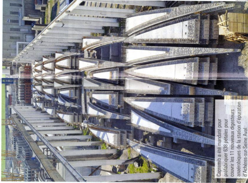
Il a fallu au préalable créer des racks de livraison spécifiques, permettant de superposer de manière indépendante trois pétales.
